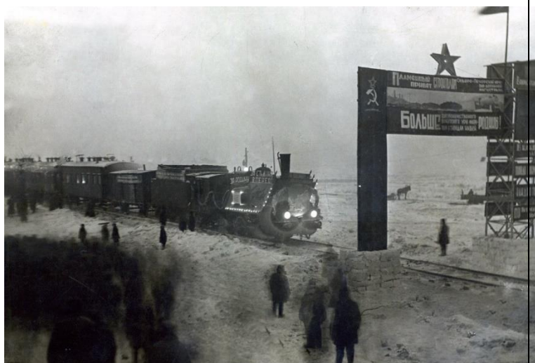
Прибытие в Воркуту первого поезда 28 декабря 1941 г. (фото из фондов Воркутинского музейно-выставочного центра)
