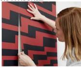
Новую полосу обоев слегка приклеить к стене примерно в 5 мм от предыдущей.
