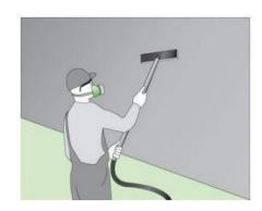
Процедуру продолжают до полного устранения дефектов. После каждого этапа затирки поверхность тщательно очищается пылесосом.
